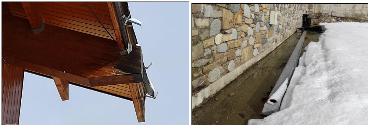
Canalera en el suelo y soportes de la misma instalados en el tejado.
