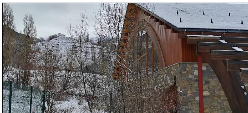
Vista de los árboles que una vez crezcan afectarán a la fachada norte del Polideportivo
