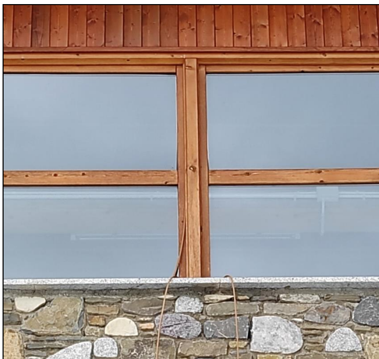
Vista de detalle de una de las ventanas con riesgo a caída del cristal.
